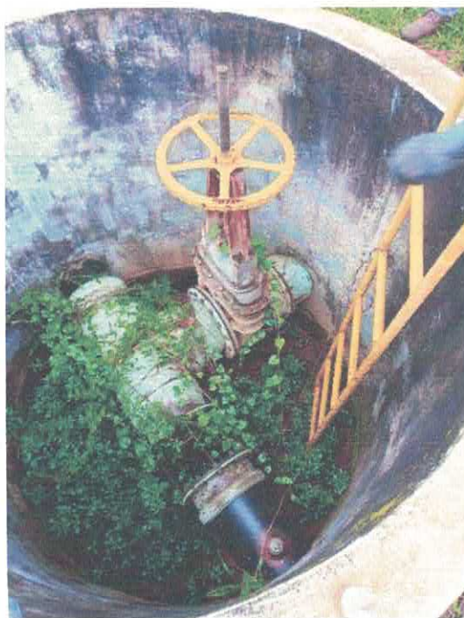
Foto 1 – Fosso de acesso á tubulação da ETA
