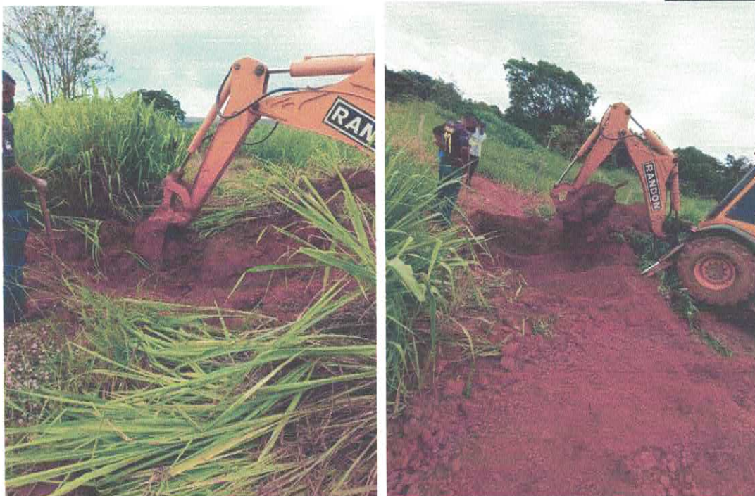
Foto 2,3 – Escavação para acesso à adutora
