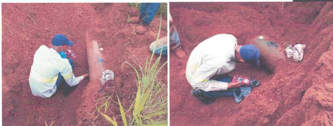
Foto 4 e 5 – Realizando Medição por ultra som.
